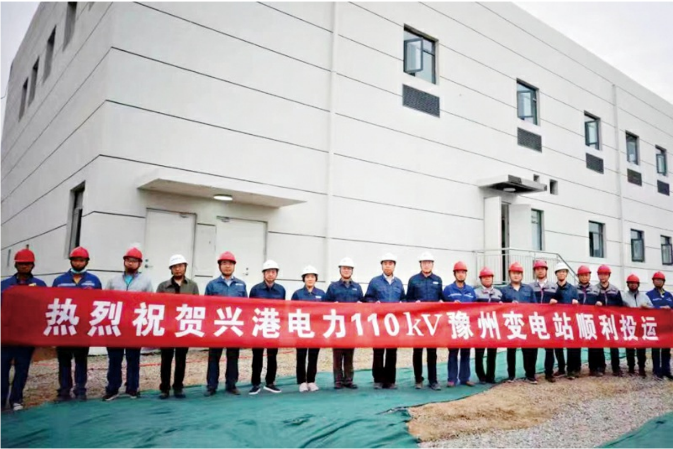
豫州变电站投运。兴港电力建设豫州变电站共用了6个月时间，于2022年9月建成，最终豫州变电站加上所有线路建设的总费用接近1亿元。图：兴港电力官网
