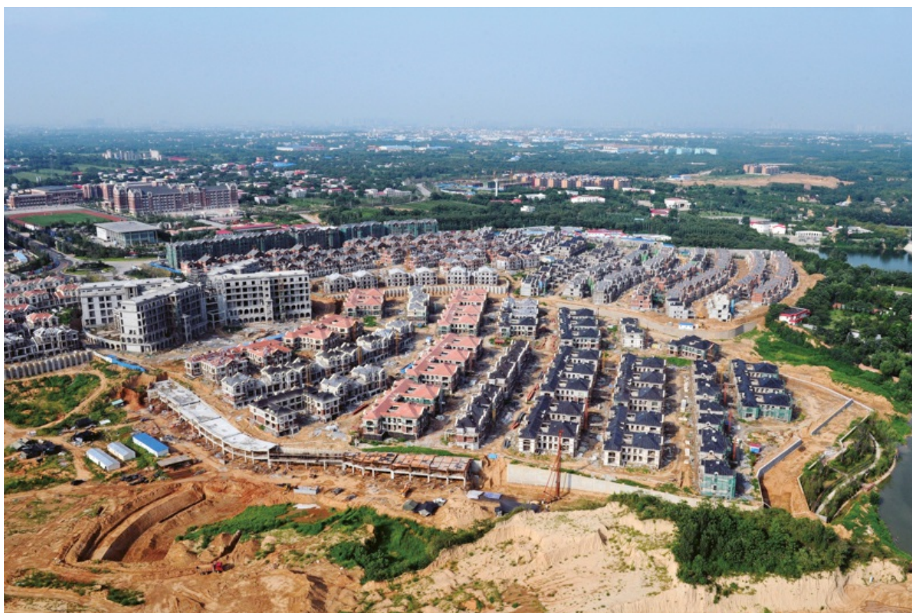
2013年8月1日，河南郑州，城郊一处建设中的高档住宅小区。中国在城镇化、工业化建设过程中，城市周边、交通沿线的大量优质耕地被占用。数据显示，1998年至2003年，全国53.33%的新增建设用地来源于耕地。
