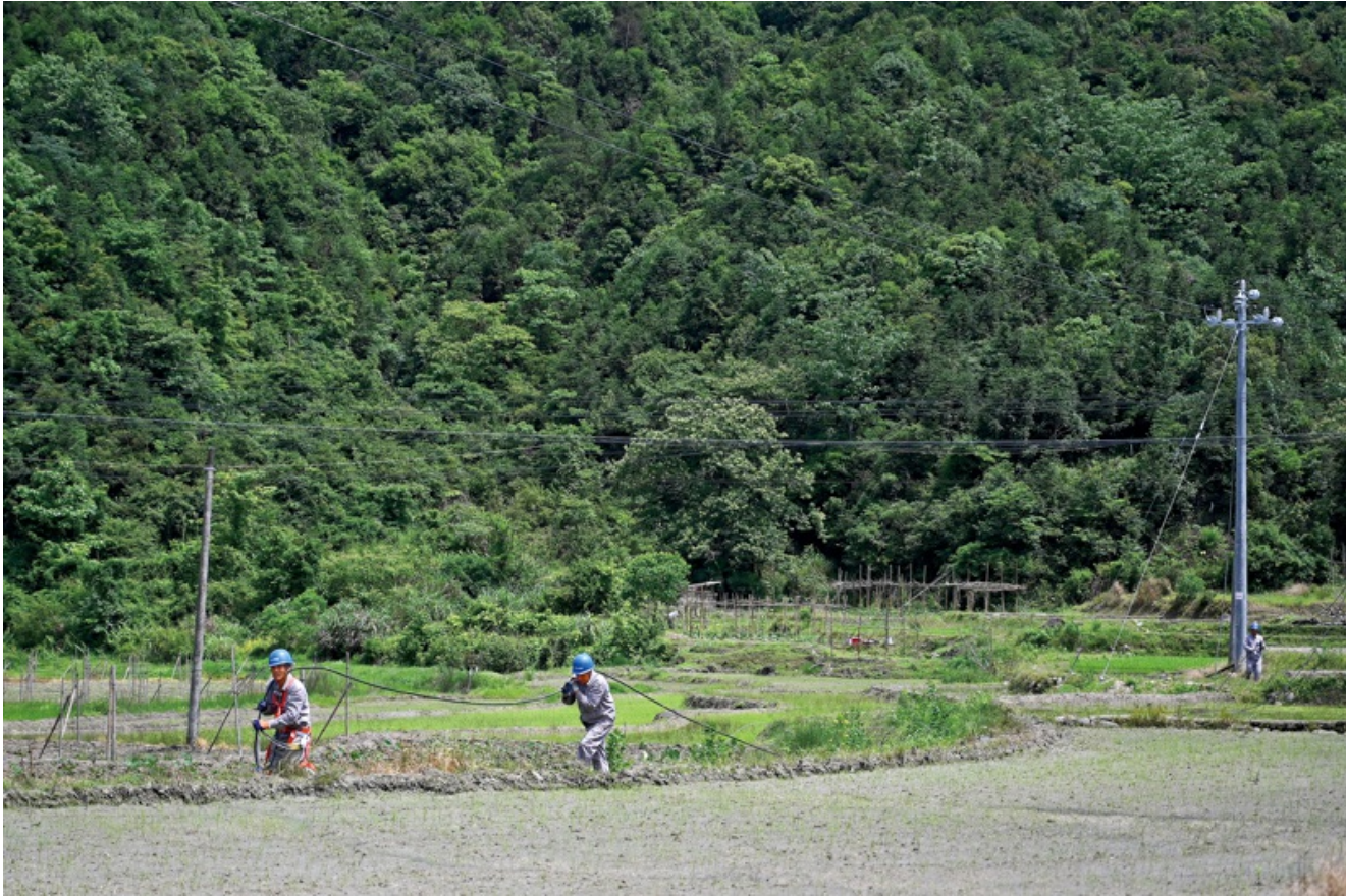
2023年5月25日，江西上饶，施工人员改造农村电网。多年来，为保障民生、扶持农业发展，中国对居民、农业等用电实行低电价政策，由工商业用户承担较高电价，由此形成政策性交叉补贴。
