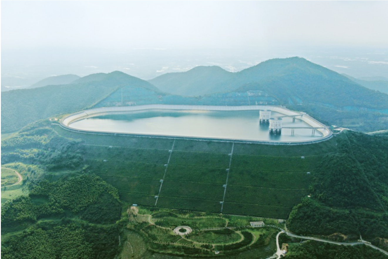
2022年7月22日，江苏常州，江苏国信溧阳抽水蓄能电站。随着更具波动性、间歇性的风电、光伏大规模上马，对电力系统的调峰、调频、备用等灵活性调节能力需求迫切。抽水蓄能作为一种大容量的储能形式，是电力系统灵活性调节资源之一。
